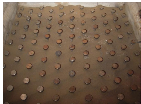
Figure 2 : La grille de fluidisation tel qu'installé dans la chambre de combustion
