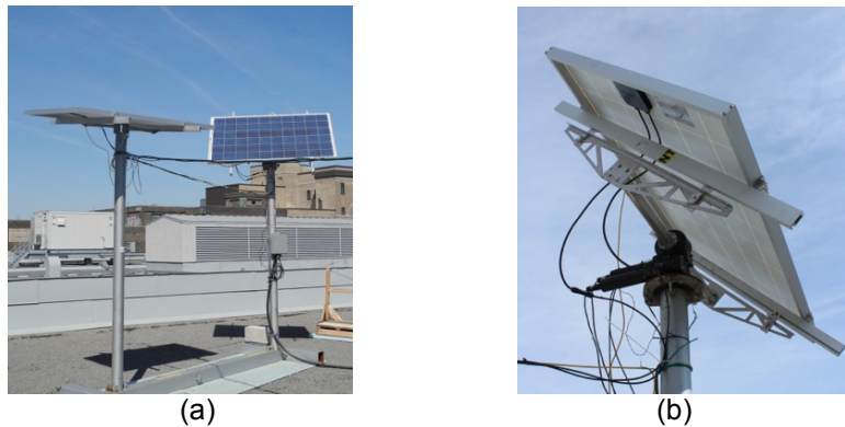
Figure 1 : Photographie du montage expérimental à Montréal (a) vue d'ensemble avec le panneau fixe horizontal à gauche et le suiveur solaire à droite (b) agrandissement illustrant les moteurs du suiveur solaire
